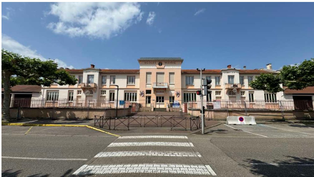
Vue d'ensemble avant travaux de la façade principale en pierre, classique et symétrique, mai 2025
