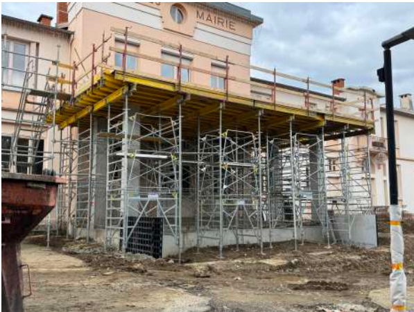
Les étapes de coffrage et d'élévation des 4 piliers en béton du nouvel auvent d'entrée
