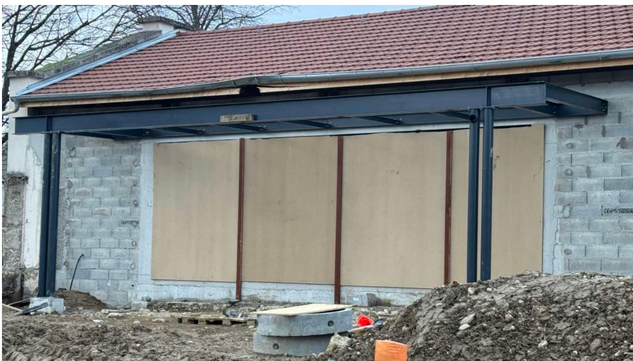
Pose d'une structure métallique externe de style auvent
