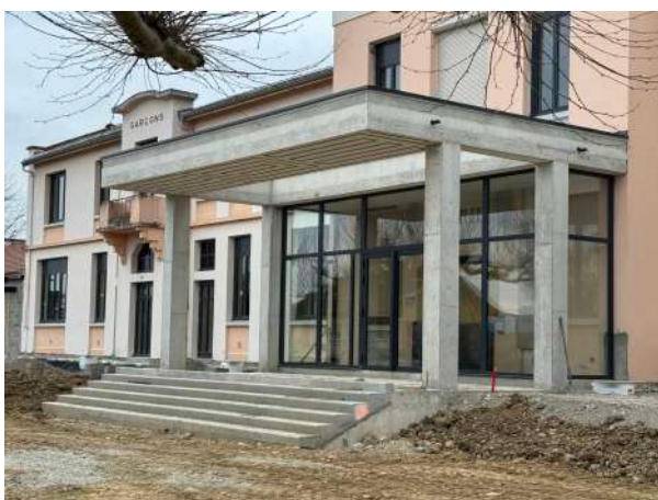
Pose de la structure vitrée s'incorporant parfaitement au nouvel auvent
