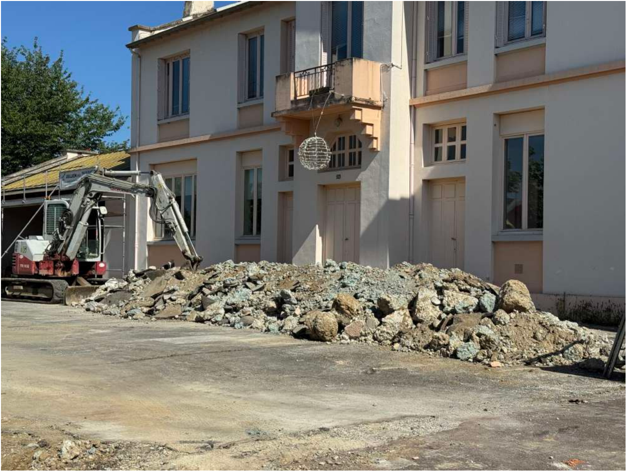
Les engins de chantier procédant à la démolition des trois perrons d'entrée Focus sur la façade après la déconstruction du balcon central des mariés
