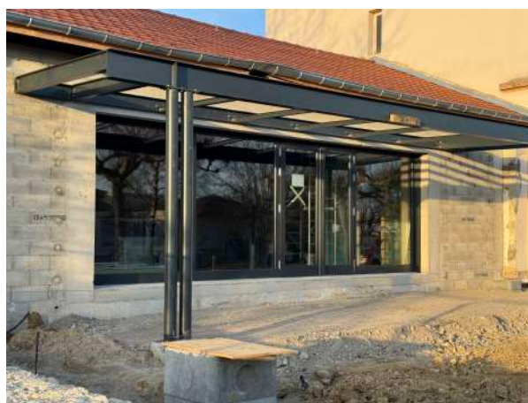
La façade vitrée moderne et lumineuse de la toute nouvelle salle des mariages
