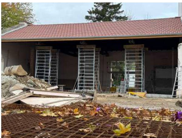
Échafaudage de maintien après retrait du pilier central
