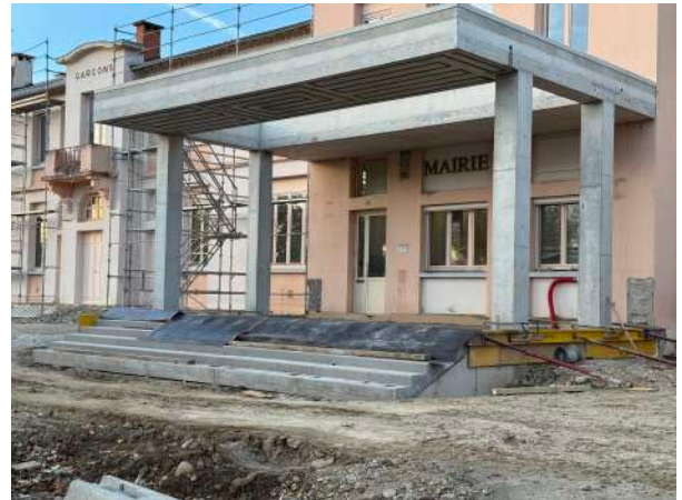
Les étapes de coffrage et d'élévation des 4 piliers en béton du nouvel auvent d'entrée
