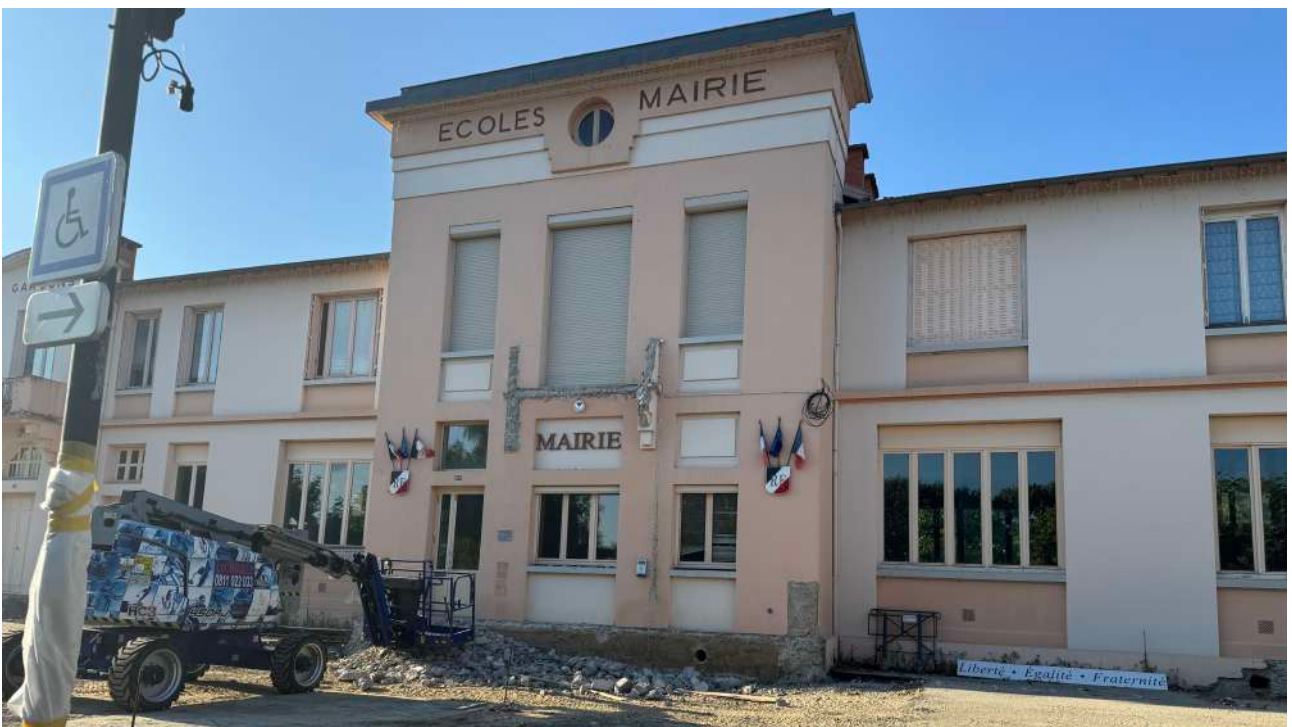
Les engins de chantier procédant à la démolition des trois perrons d'entrée Focus sur la façade après la déconstruction du balcon central des mariés
