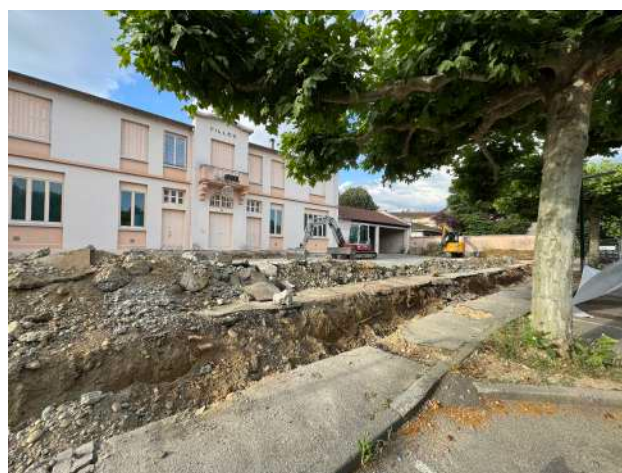
Les murets d'enceinte mis à nu après la dépose des grilles et des portillons Amas de gravats issus de la démolition du muret délimitant la rue de l'Europe
