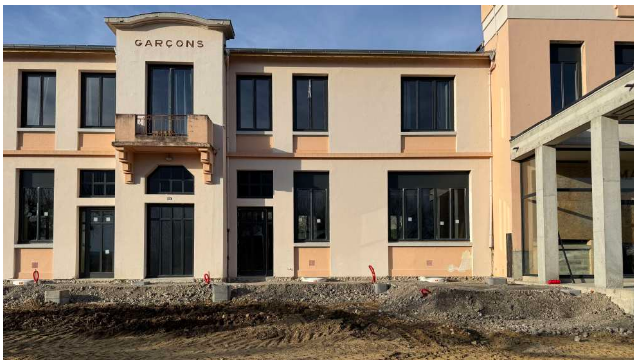
La façade principale avec ses nouvelles menuiseries d'un noir élégant
