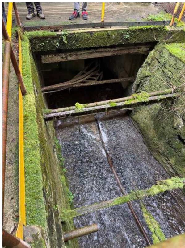
Entrée du canal dans l'usine
