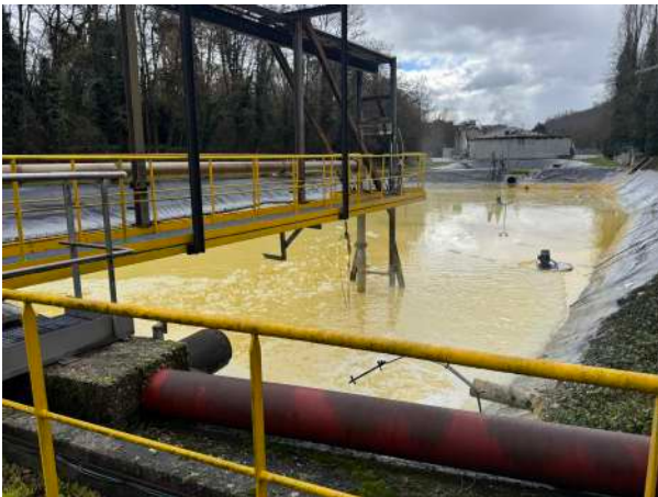
Agitateurs en surface de la Lagune
