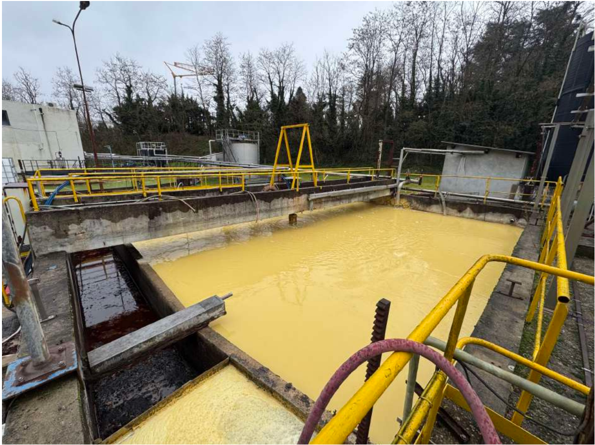
Bassin de Neutralisation du PH avec son système d'agitation
