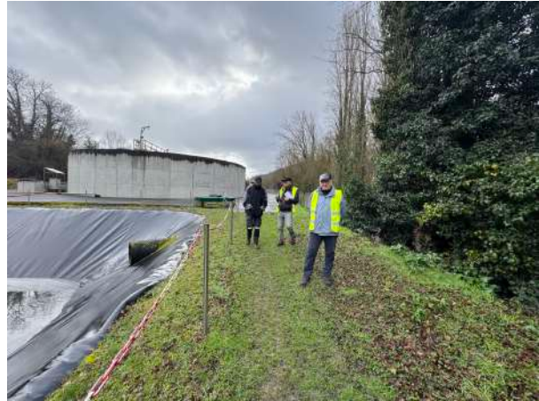
Bords du bassin de rétention eaux pluviales
