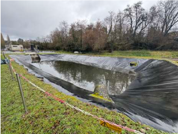
Bassin de rétention d'eaux pluviales
