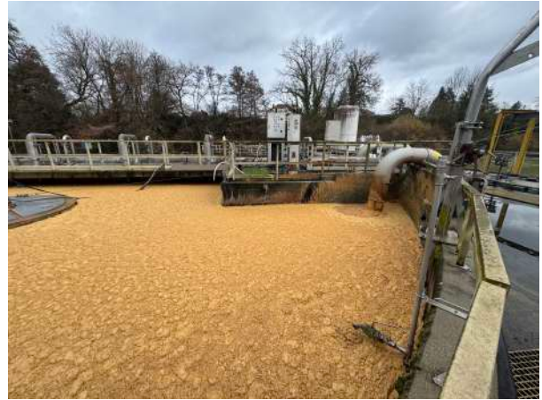
Boue activée en circuit fermé
