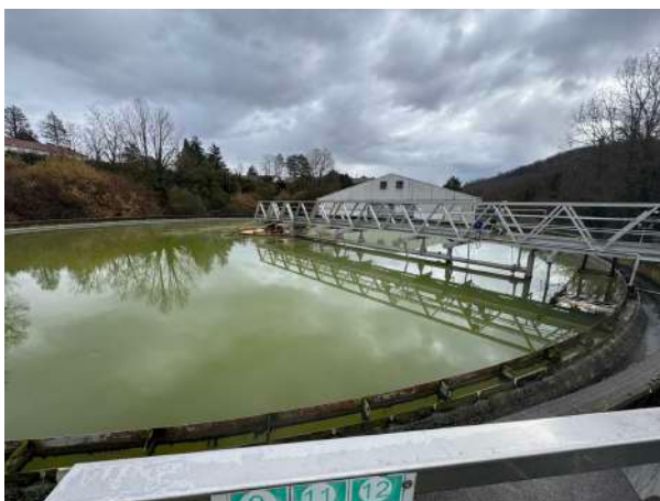
Bassin de Clarification
