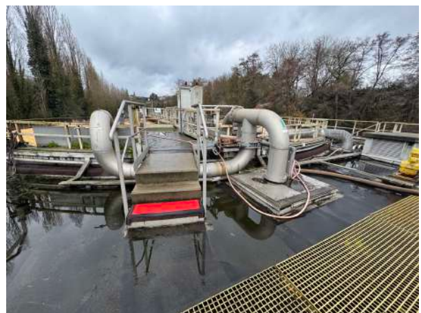
Pont du Clarificateur
