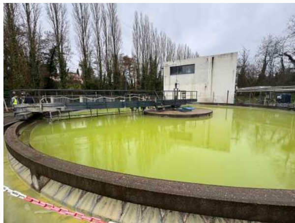
Bassin Turbo-Circulateur et son pont racleur
