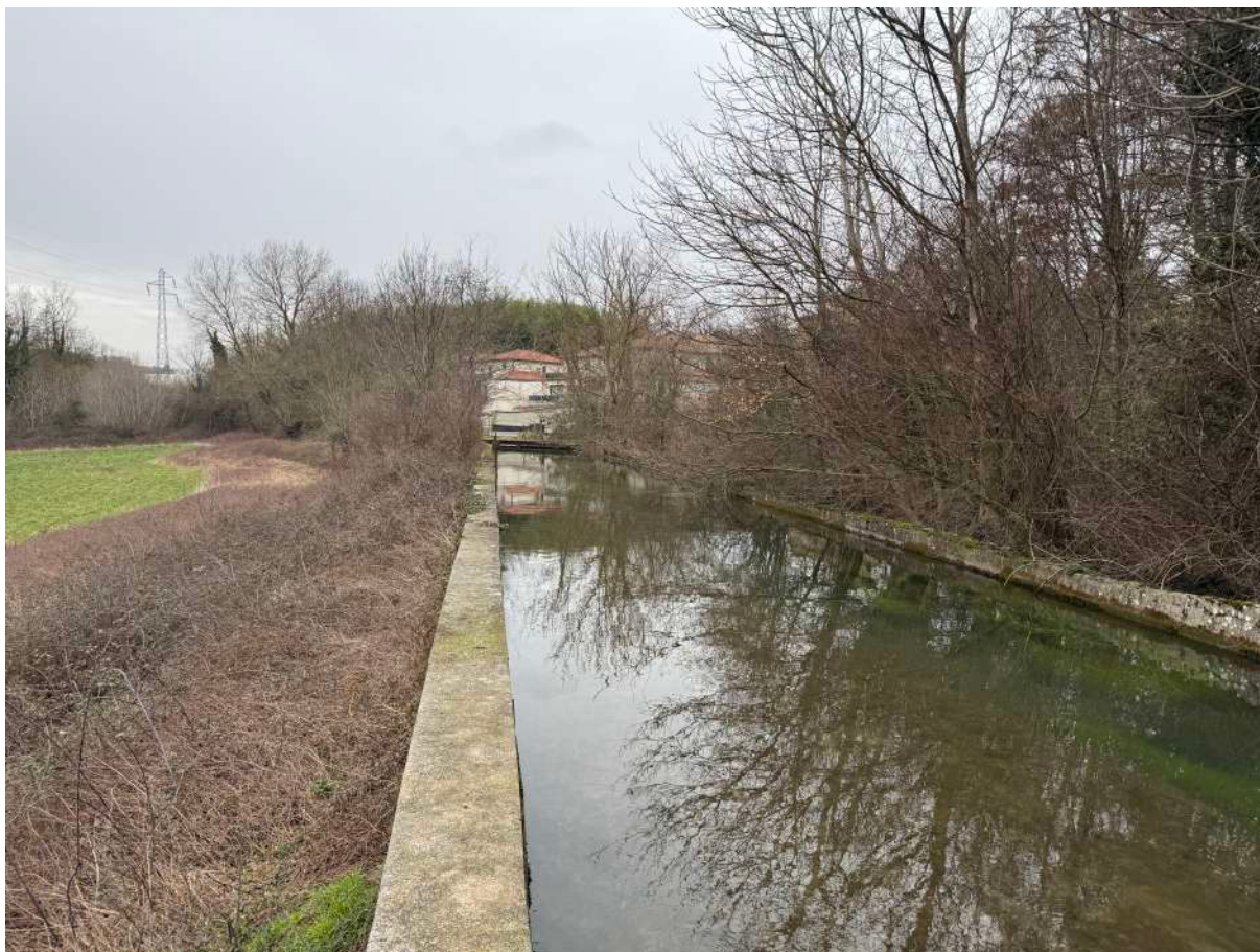
Canal de la Gère avant l'entrée dans la papeterie
