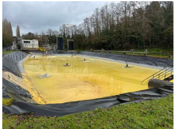
Bassin de la Lagune d'Aération
