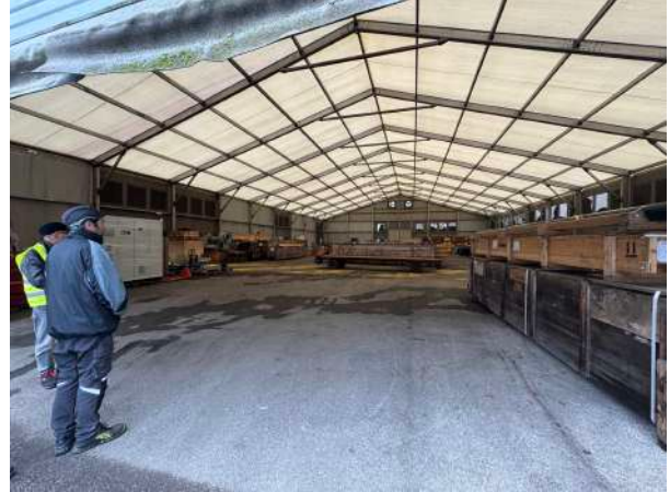
Reconverti zone stockage Pièces détachées
