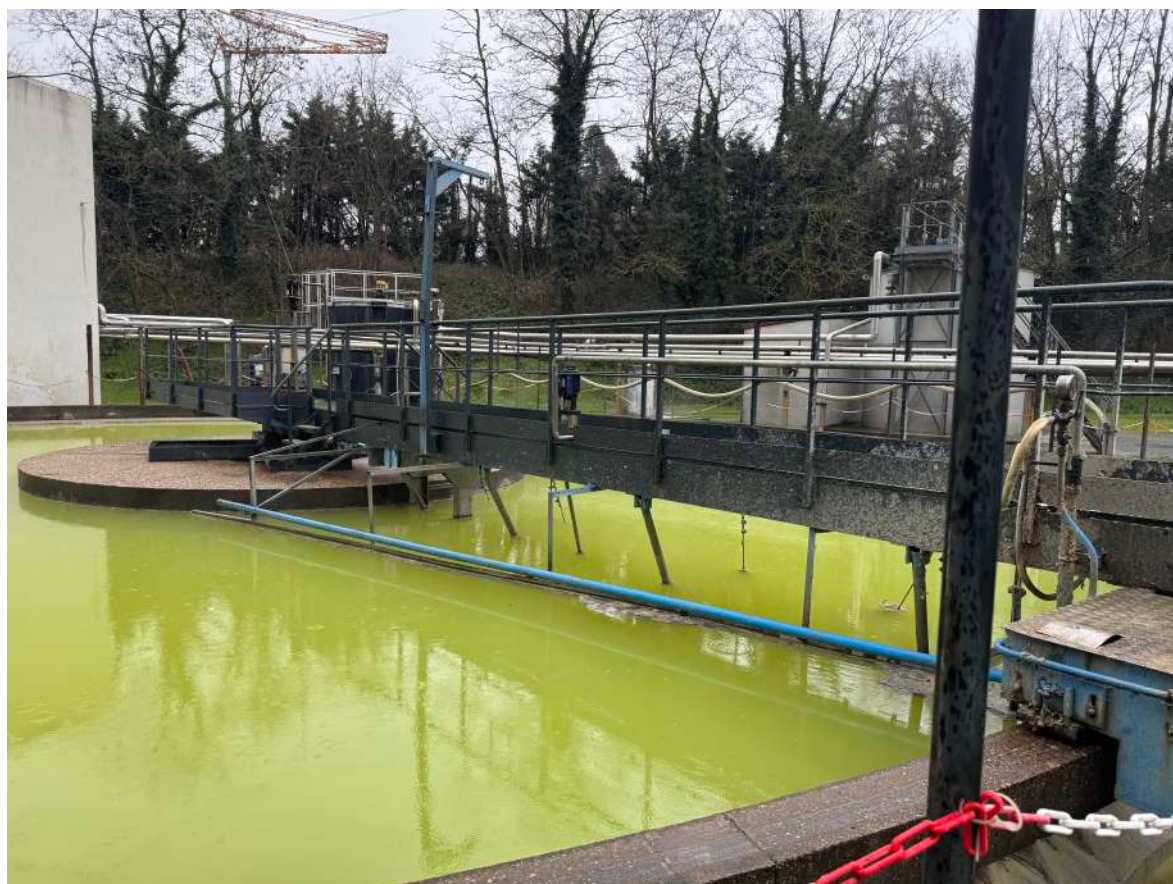
Pont racleur et l'agitateur central
