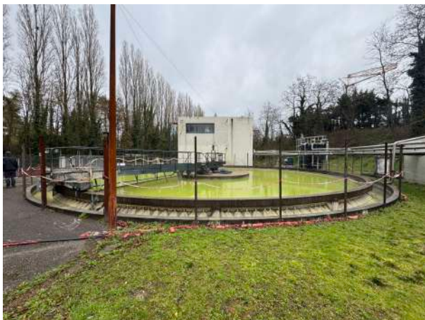
Bassin circulaire Turbo-Circulateur
