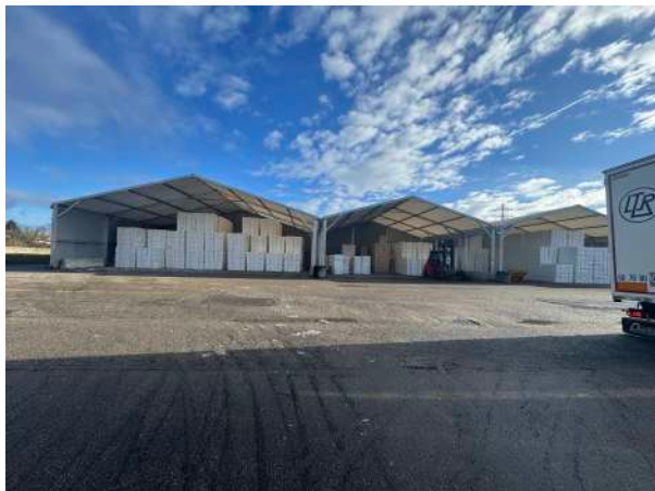
Stockage des balles de cellulose
