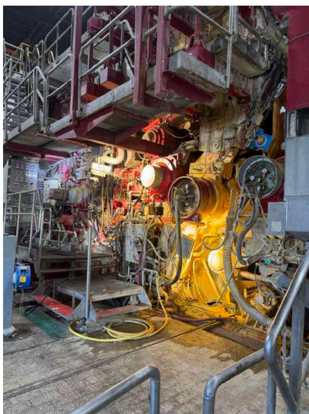
Vue du transfert avec sa passerelle
