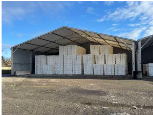
Stockage des balles de cellulose
