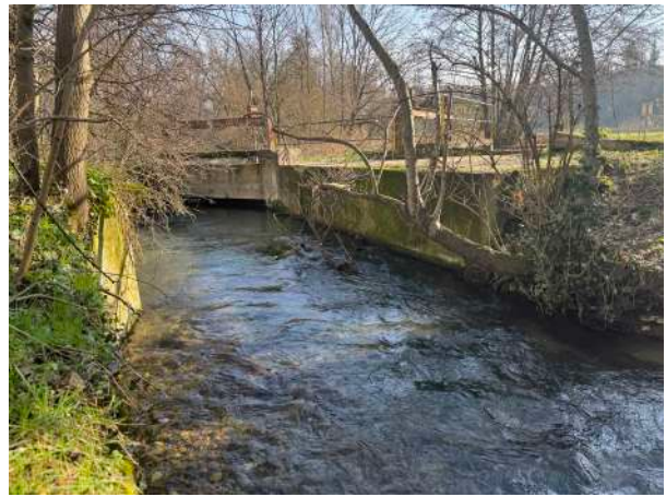
Début du canal de la papeterie après l'écluse de la Gère
