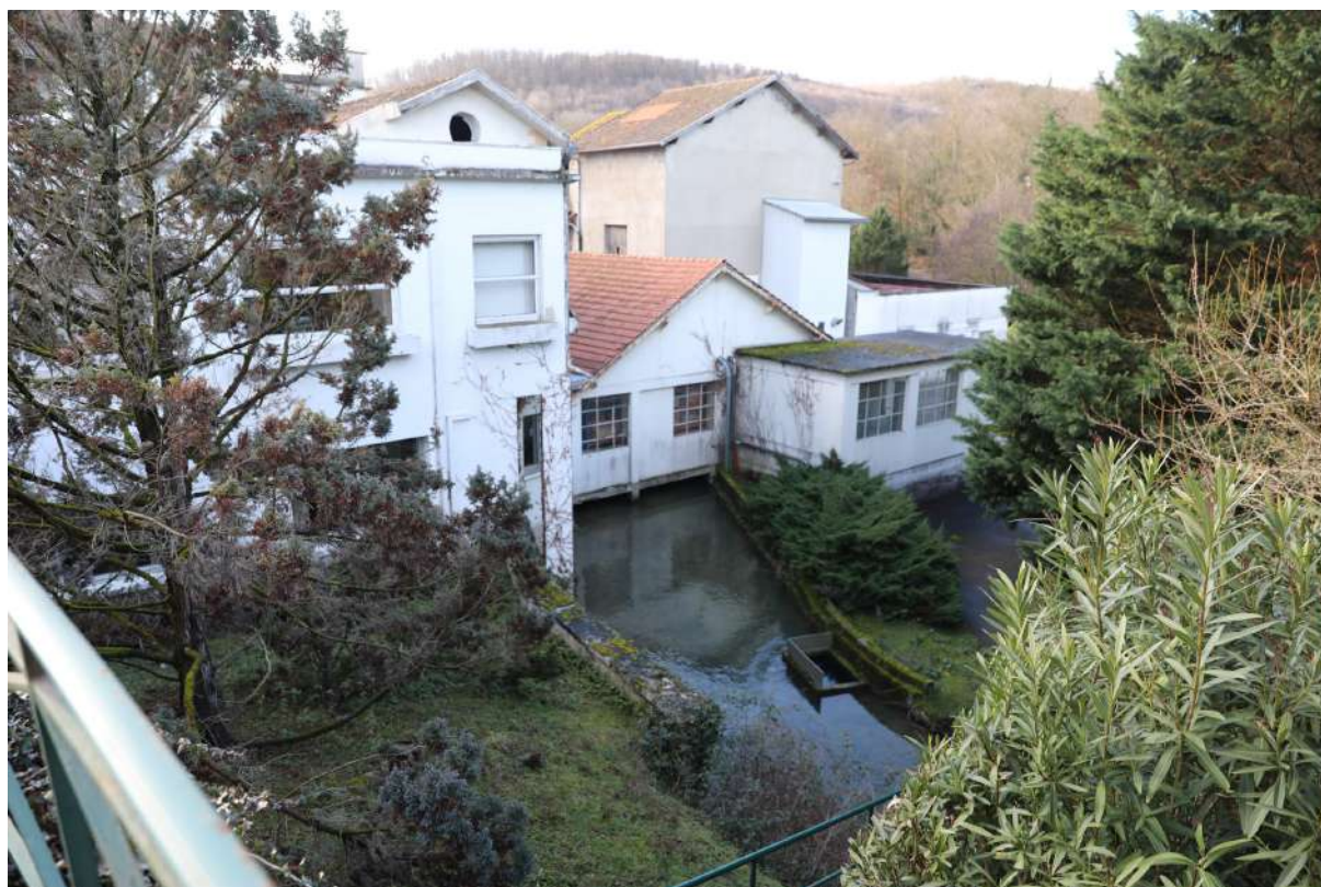
Sortie du canal de la Gère dans la papeterie
