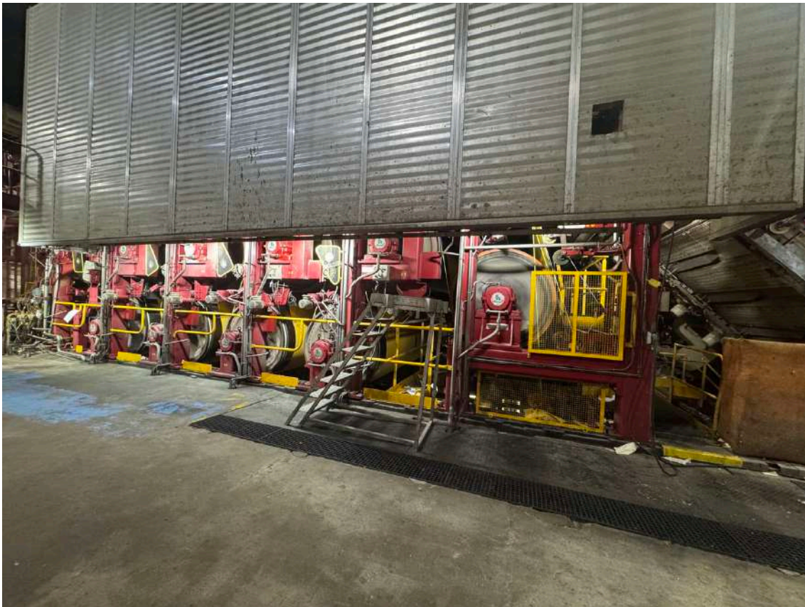
Batterie des 10 cylindres sécheurs post-séchage
