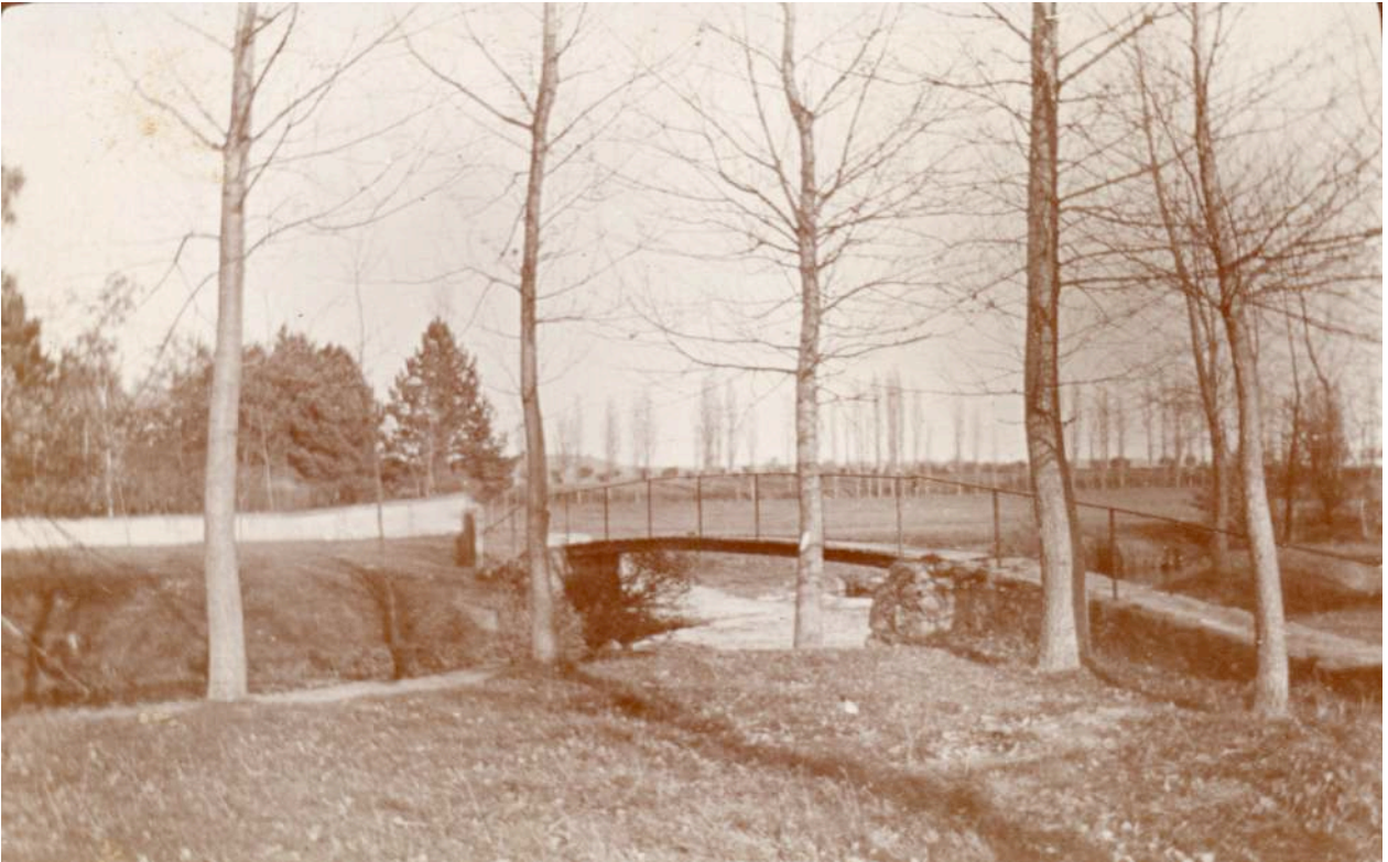
La passerelle d'Aiguebelle au début du XXème siècle – photo collection Hervé de Martène
