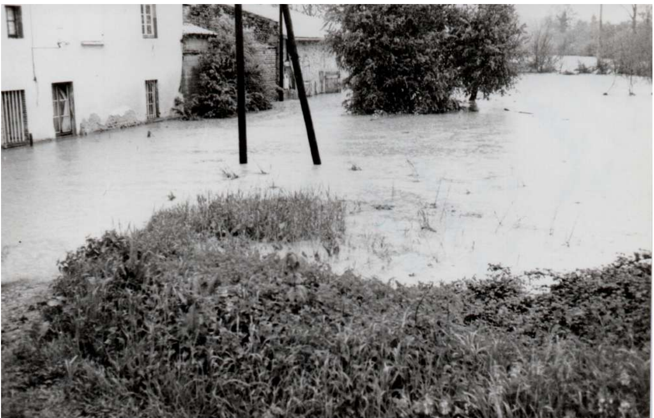
La Vesonne déborde au niveau de la ferme de la Gabetière – 1 er mai 1983 Photo André Levet
